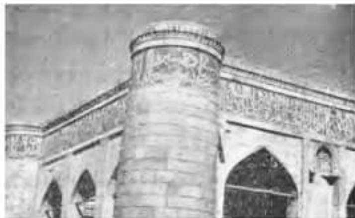
یکی از مناره های چهارگانه خدابخانه
